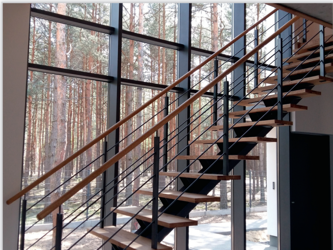
Schody z balustradą stalową
