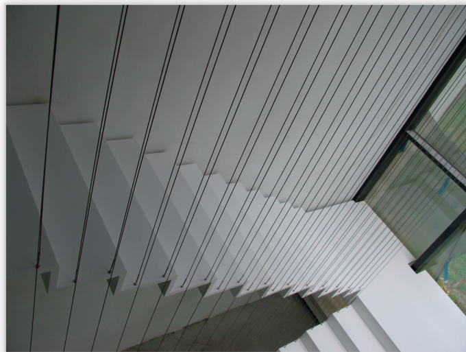
Schody dywanowe malowane proszkowo, balustrada linki nierdzewne
