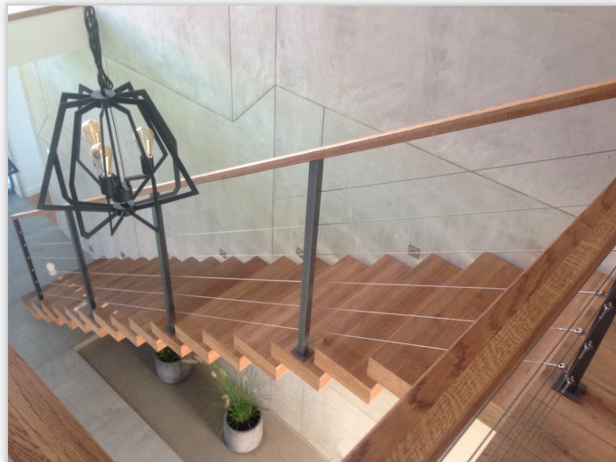
Schody wspornikowe, balustrada malowana proszkowo, wypełnienie linki nierdzewne
